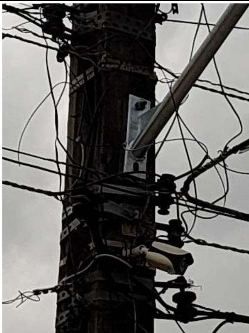
Aqui um exemplo do braço fixado corretamente. Observe que com dois parafusos ou um parafuso e uma abraçadeira, não seja possível a colocação de dois parafusos em razão do tipo de furação do poste, o braço não gira.
